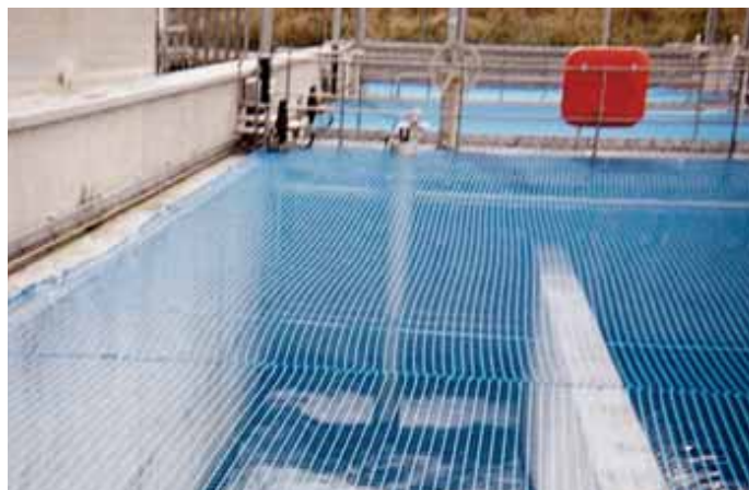
Filet de sécurité sur un bassin d'épuration
